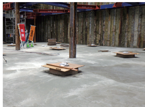
均しコンクリート打設（地上から14.9mの深さ）
