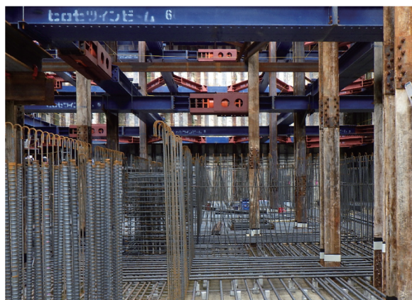
鉄筋設置状況
