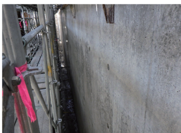
壁コンクリート一部打設完了状況
