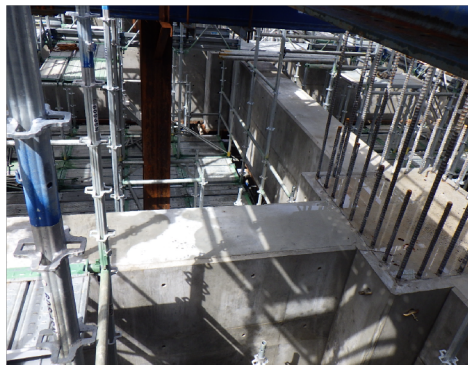
中層梁コンクリート
