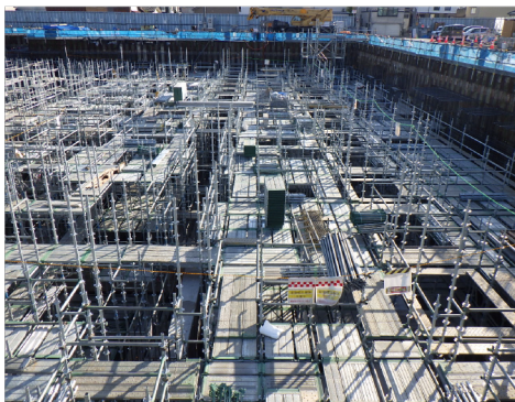
山留支保工撤去完了、型枠支保工状況
