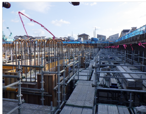
壁コンクリート状況
