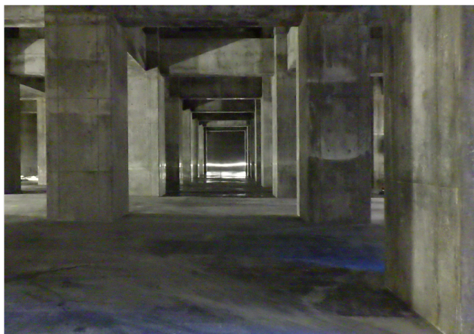
南側調整池完成写真
