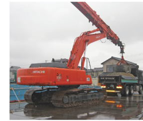
掘削土積込作業
