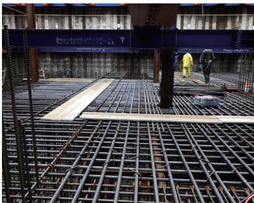
鉄筋設置状況
