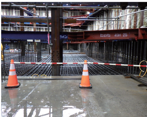
鉄筋設置状況
