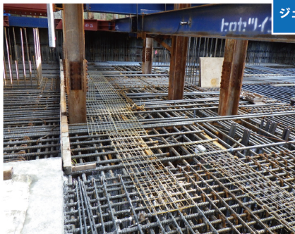
鉄筋設置状況
