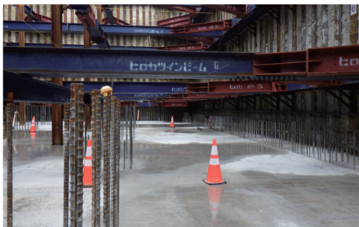
底版コンクリート20ヶ所目完了
