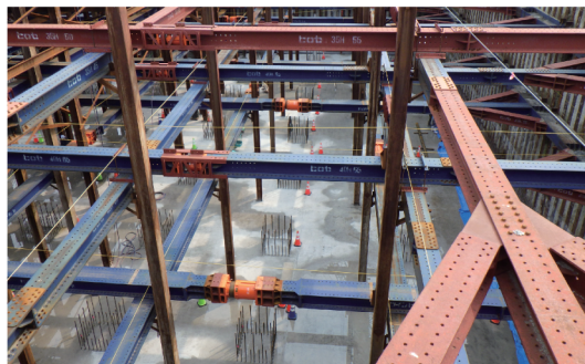
4段目支保工鋼材撤去完了
