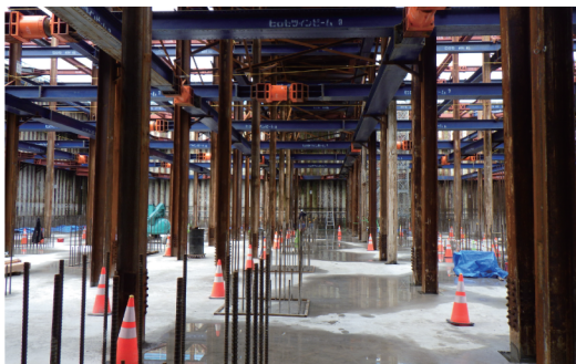
底版コンクリート打設完了
