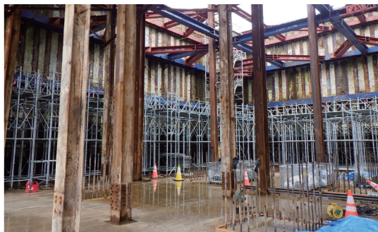
坑内型枠支保工設置状況
