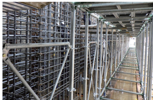
壁・柱鉄筋組立状況
