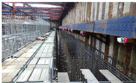
壁鉄筋組立状況
