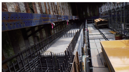
壁鉄筋組立状況
