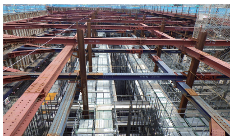
壁鉄筋組立状況
