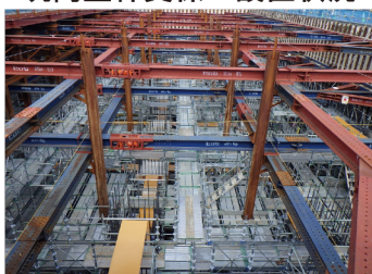
壁コンクリート一部打設完了状況
