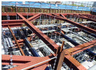
中層梁一部打設完了状況
