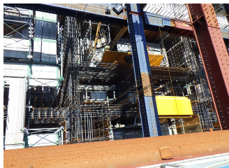
中層梁一部打設完了状況
