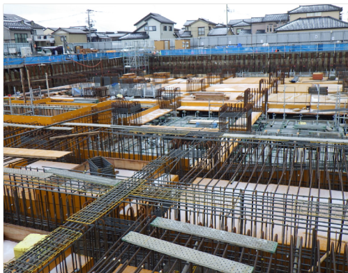
スラブコンクリート状況
