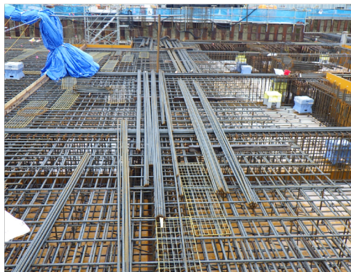
鉄筋工状況
