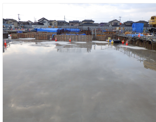
スラブコンクリート状況
