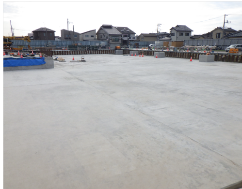
埋戻し前の調整池の状況
