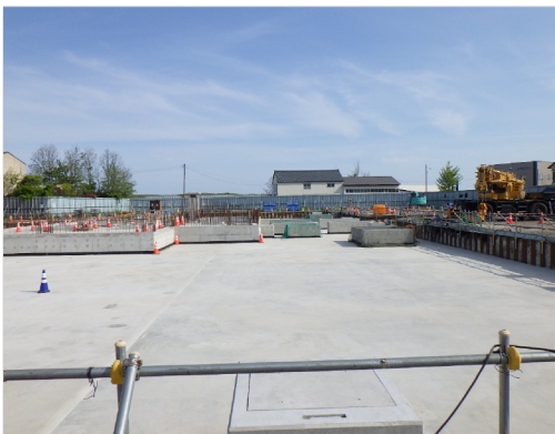
スラブコンクリート状況（埋め戻し前）
