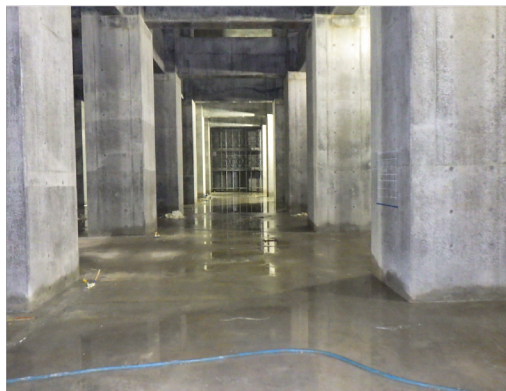
南側調整池内部状況
