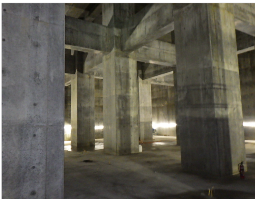
南側調整池内部状況
