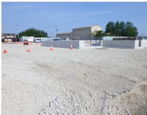
埋め戻し完了
