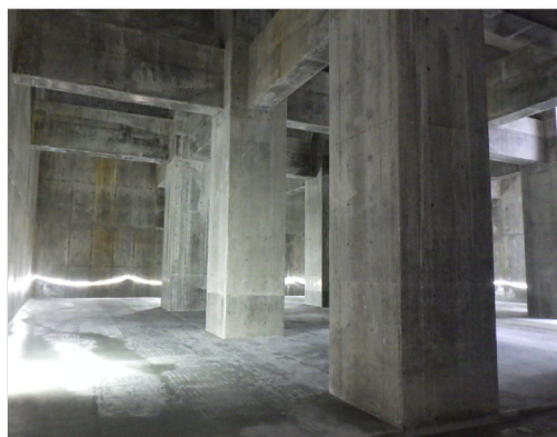
北側調整池完成写真
